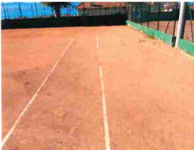
Lignes en très mauvais
