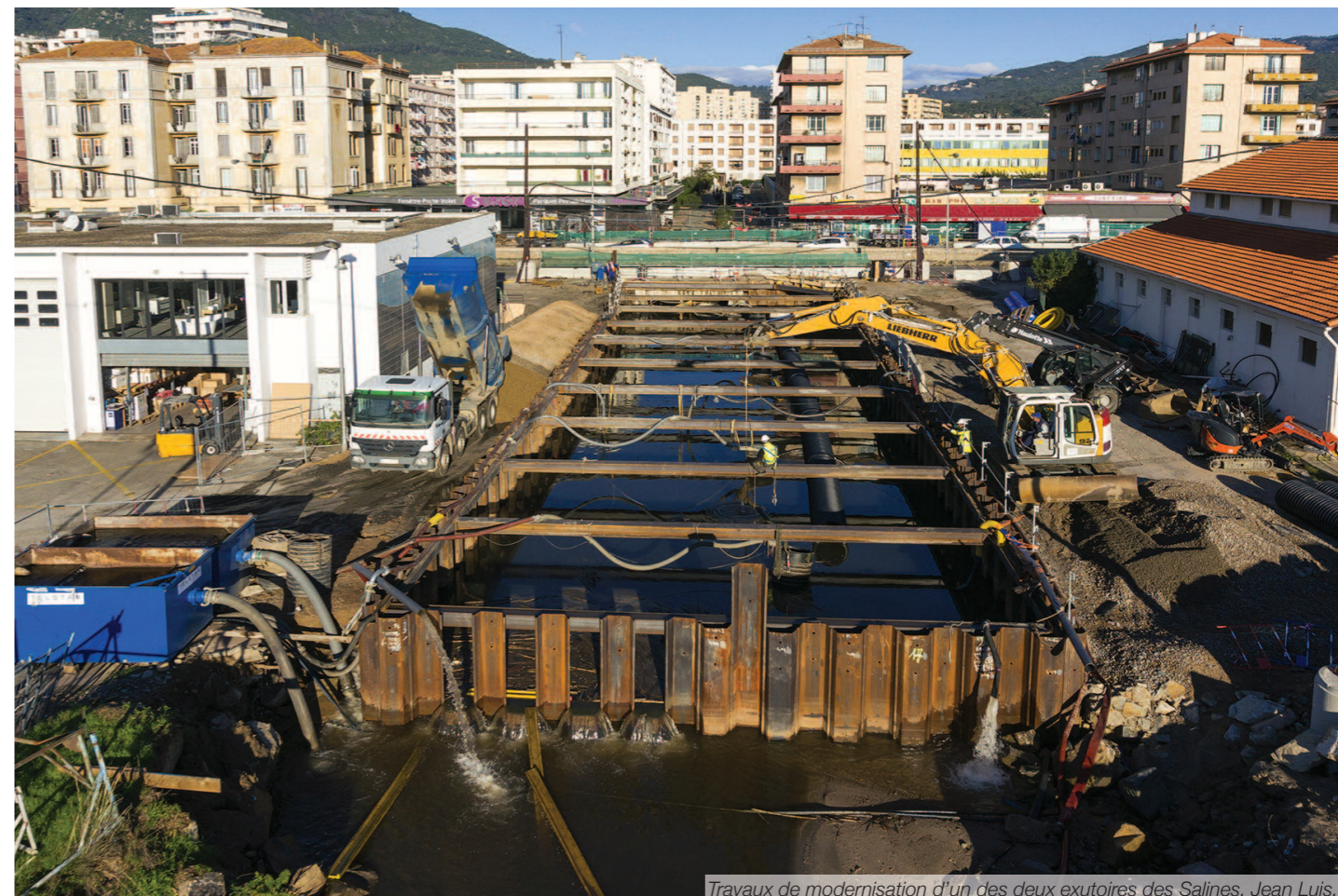
Travaux de modernisation d'un des deux exutoires des Salines, Jean Luis.
