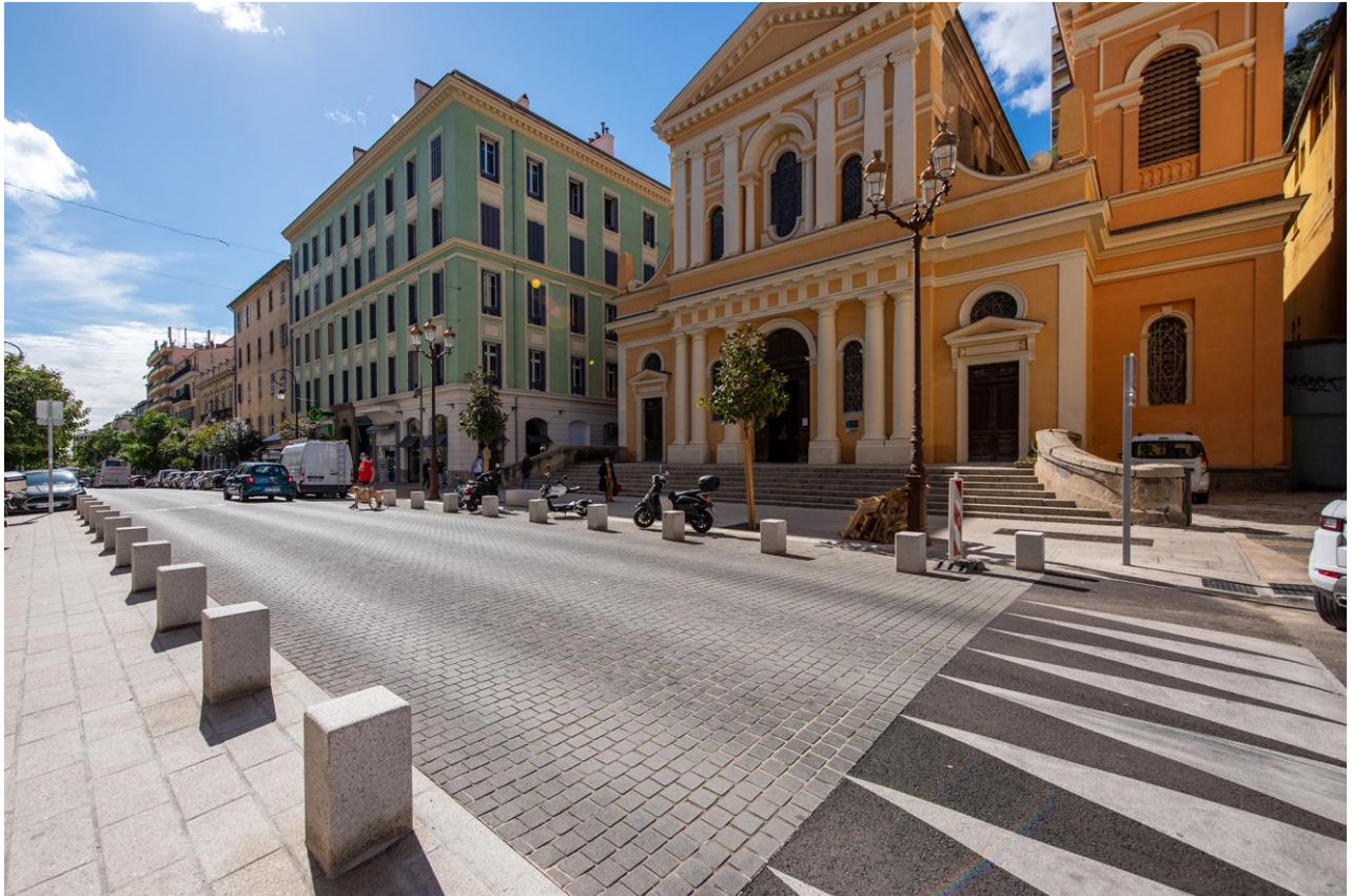
Rénovation finalisée du parvis Saint Roch
